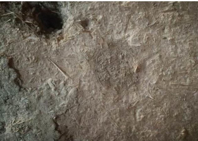
图 5-44 地仗填补干燥后效果
