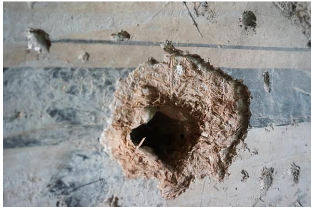
图 2-58 西壁下部孔洞
