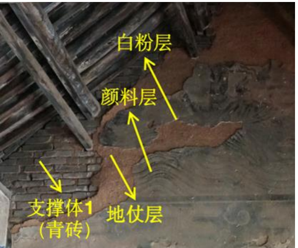
图 3-7 天宁寺大雄宝殿东壁顶部壁画结构示意图
