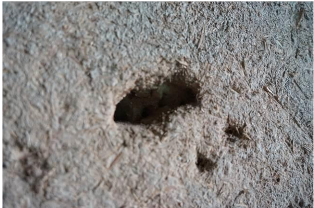
图 2-59 西壁下部孔洞
