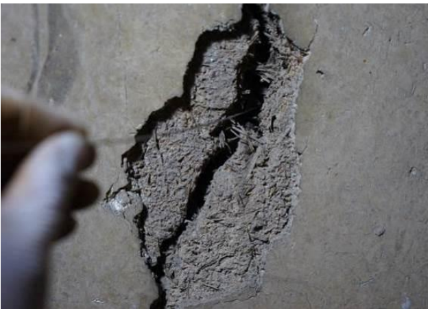
图 5-55 清理裂隙内部碎屑
