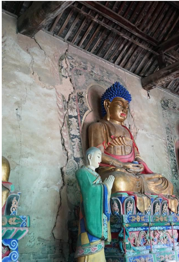
图 2-56 主尊左侧裂隙
