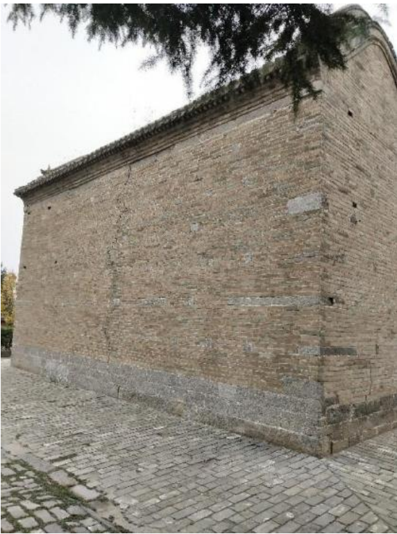
图 2-4 建筑北侧地面铺装
