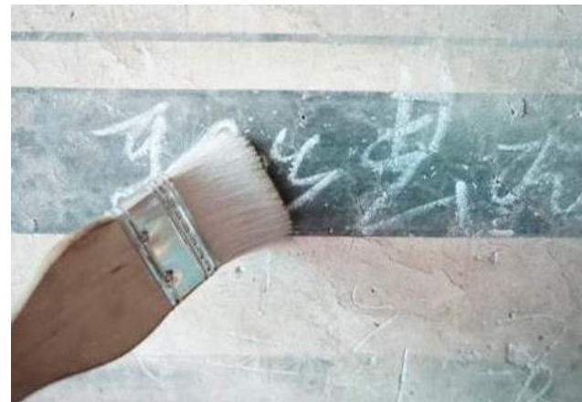
图 5-86 软毛刷清除表层浮土
