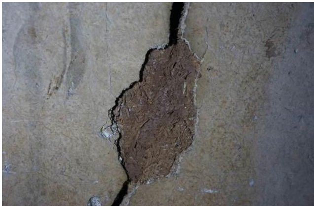
图 5-58 裂隙疏松地仗加固
