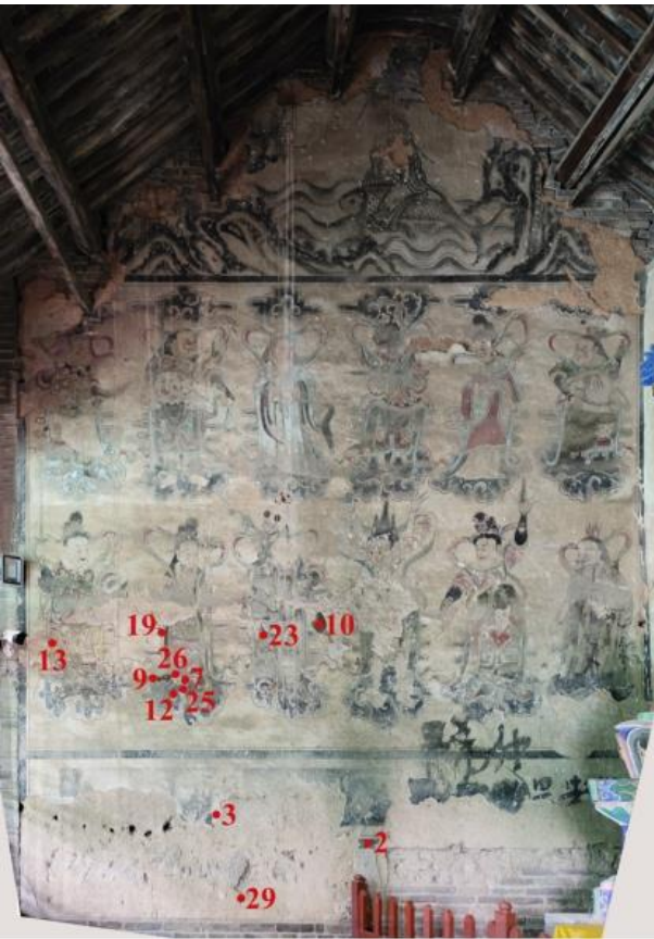
图 3-3 现场无损/微损检测西墙测试点
