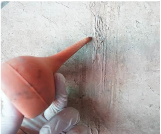
图 5-72 洗耳球轻吹表面浮尘
