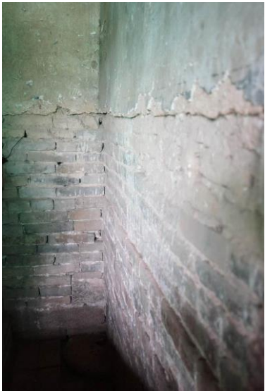
图 2-9 上部土坯砖砌筑层
