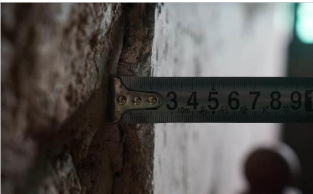
图 2-12 泥层、基底层厚度
