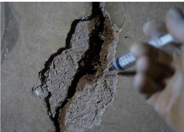
图 5-58 裂隙疏松地仗加固
