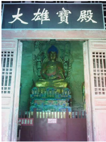
图 2-18 北壁裂隙影像图
