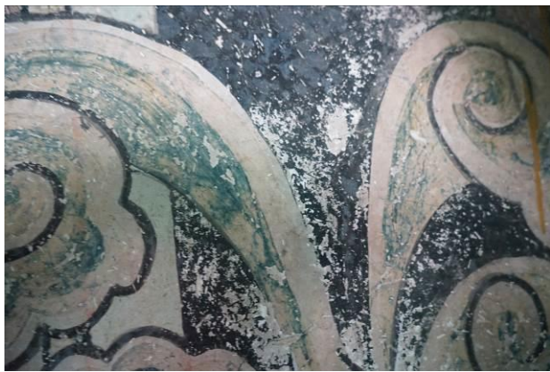
图 2-54 壁画颜料层局部点状脱落
