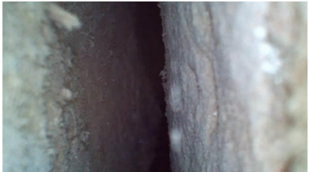
图 2-46 内窥镜下空鼓区域基底层与泥地仗层分离
