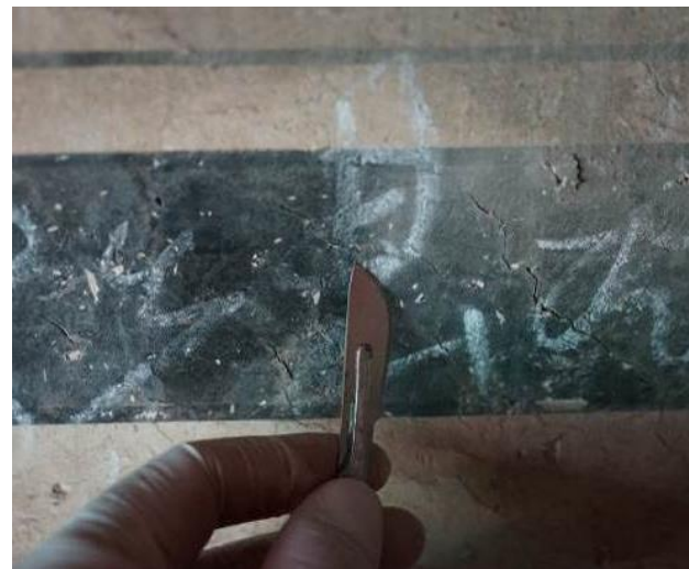
图 5-89 手术刀剔除法进行清理
