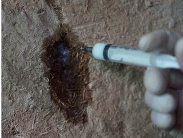
图 5-34 疏松地仗加固
