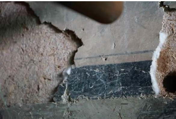
图 5-20 空鼓区域裂隙预封护
