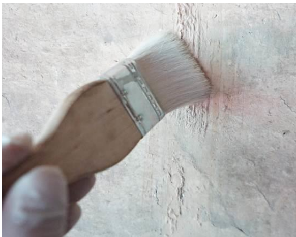
图 5-73 软毛刷清除表层浮土
