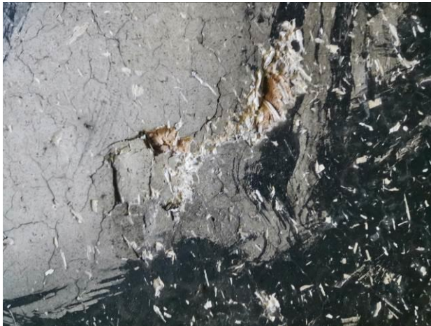
图 2-52 壁画颜料层局部片状脱落
