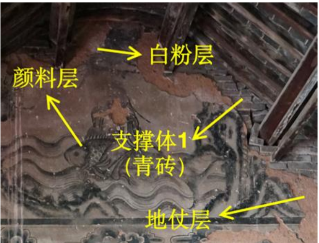
图 3-6 天宁寺大雄宝殿西壁顶部壁画结构示意图
