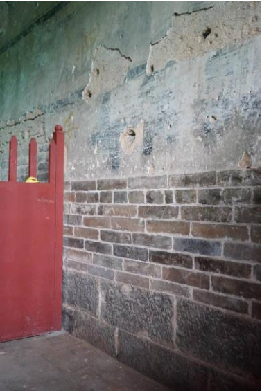
图 2-8 底部条石砌筑层及中部青砖砌筑层
