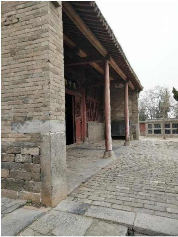
图 2-7 建筑南侧铺装
