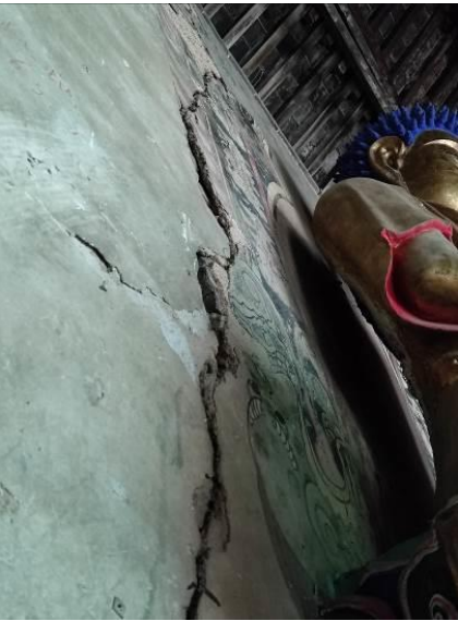
图 2-20 主尊左侧裂隙
