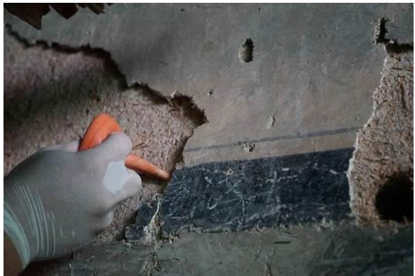
图 5-15 洗耳球吹净积尘
