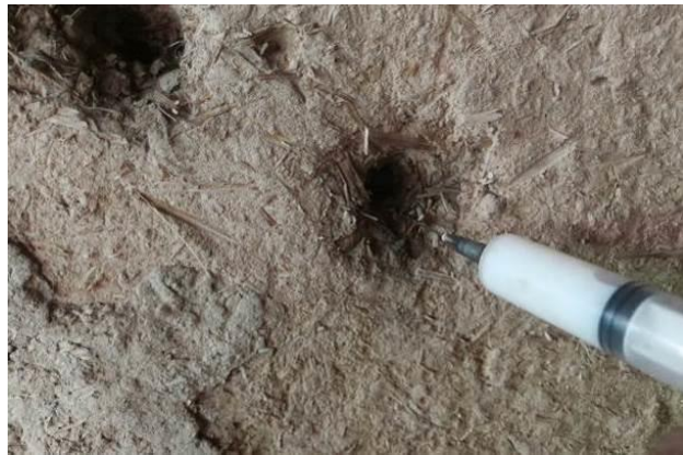
图 5-42 疏松地仗层加固
