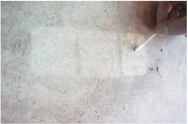
图 5-64 洗耳球轻吹表面浮尘
