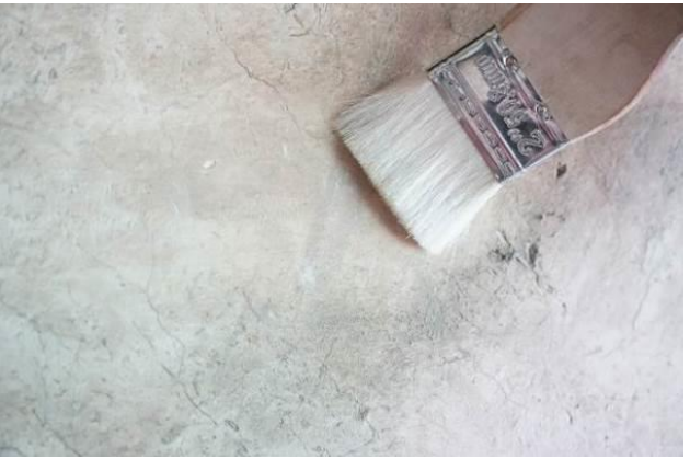
图 5-65 软毛刷清除表层浮土
