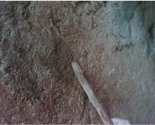
图 5-36 填补地仗表面效果处理
